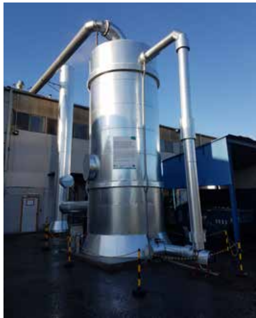
Działający w przemyśle lakierniczym bioreaktor KBT firmy Ekoinwentyka sp. z o.o. dla przepływu oczyszczonego powietrza 10 000 m 3 /h. Źródło: Ekoinwentyka
